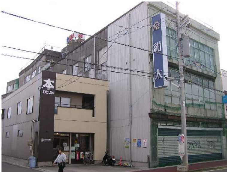
被災した老舗店舗同士の共同建替え 解体だけで1億円もかかるプロジェクト
